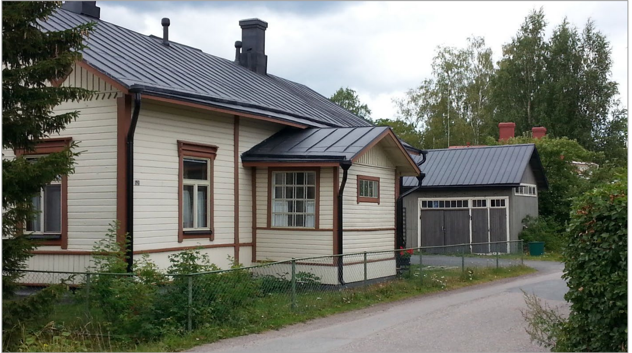
Käsityöläiskadun varrella sijaitseva kaava-alueen kiinteistö 61-7-32-9 nähtynä Palotorilta.
